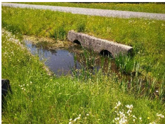
Ouvrage 1 - Franchissement de la RD
